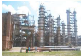
Кирши. Нефтеперерабатывающий завод
